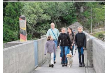
Oben: Die Grenze auf der Staumauer der Eckertalsperre bei Bad Harzburg (Niedersachsen) 1982. Unten: Heute können Fußgänger über die Staumauer gehen. Ein alter Grenzpfahl (links) erinnert an die Geschichte.
